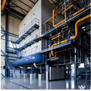
Традиционные серии котлов ПТВМ, КВ-ГМ, КВ-Р тепловой мощностью от 10 до 209МВт для сжигания газа, жидкого и твёрдого топлива.
