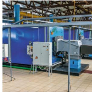
Газоплотные водотрубные котлы туннельного исполнения мощностью до 10МВт.
